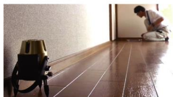
基礎部分や外壁・床のひび割れを 計測。建物の傾きも計測。
